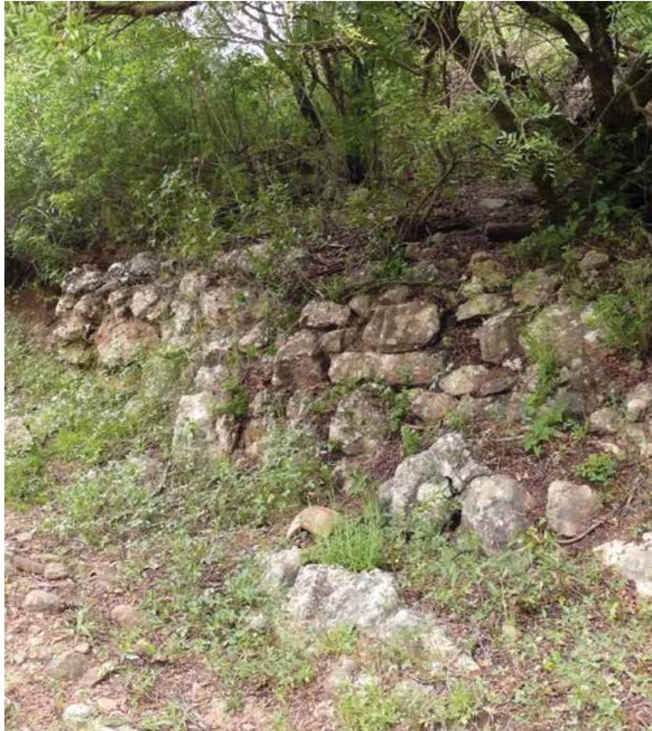
6 - Muro de pedra seca de suporte de um socalco
