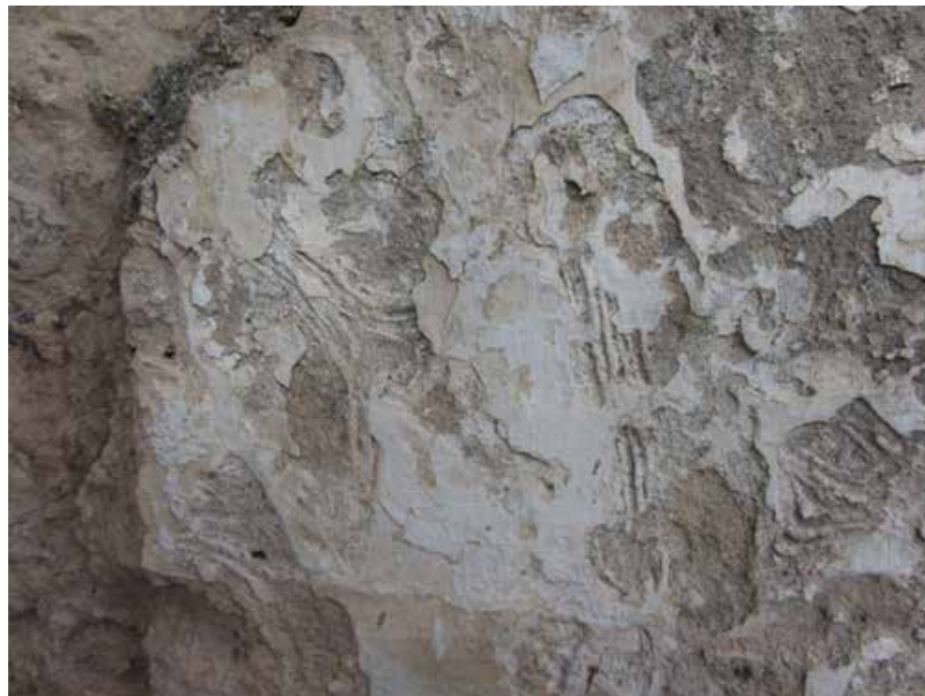
Figura 5. Pormenor ilustrando as sucessivas fases da vida do reboco, com os anéis de Liesegang do reboco estrutural de base, o acabamento por barramento e algumas camadas de caiação de manutenção subsequentes.
