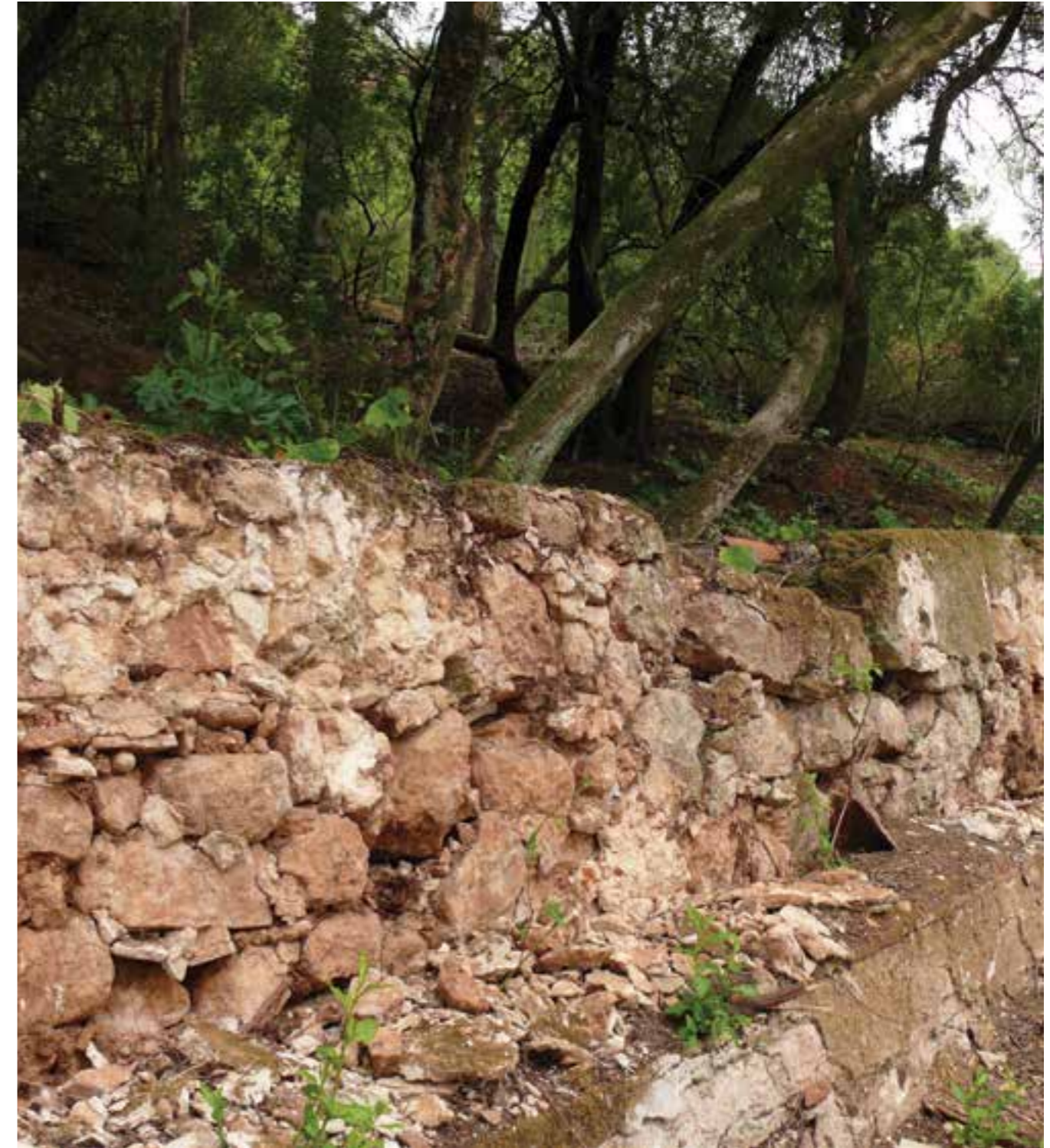
7 - Suporte de socalco e de uma caleira de distribuição de água
