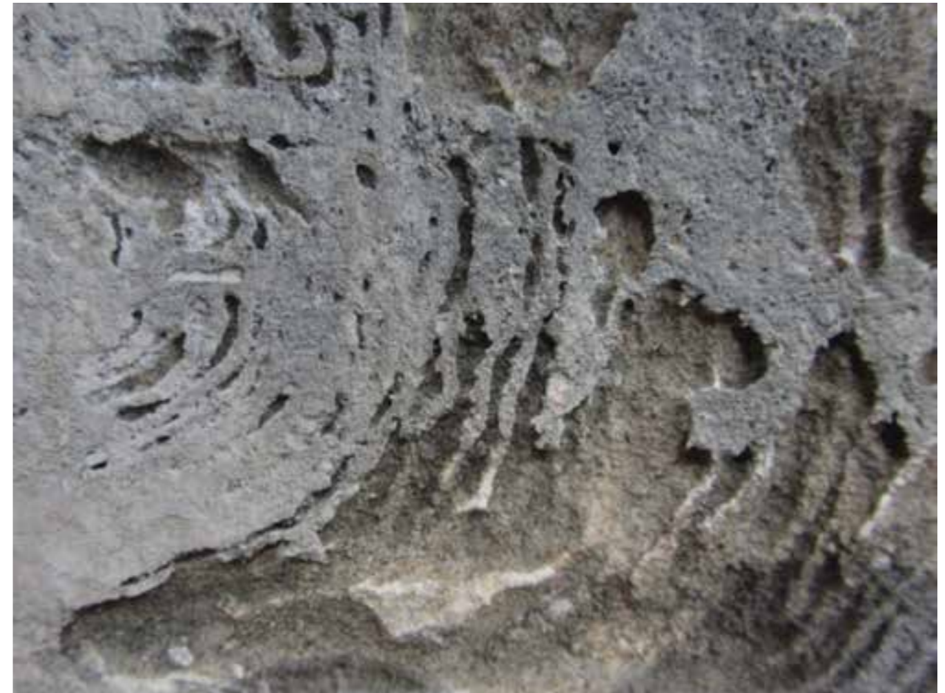
Pormenor de micro-lacunas associadas aos anéis de Liesegang onde as acções de colmatação exigem maior cuidado e rigor.
