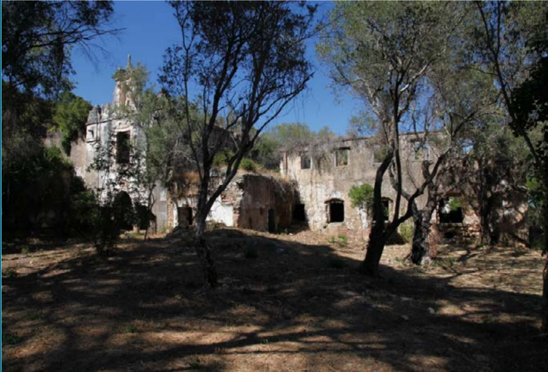
Fachada oeste antes da intervenção de 2012
