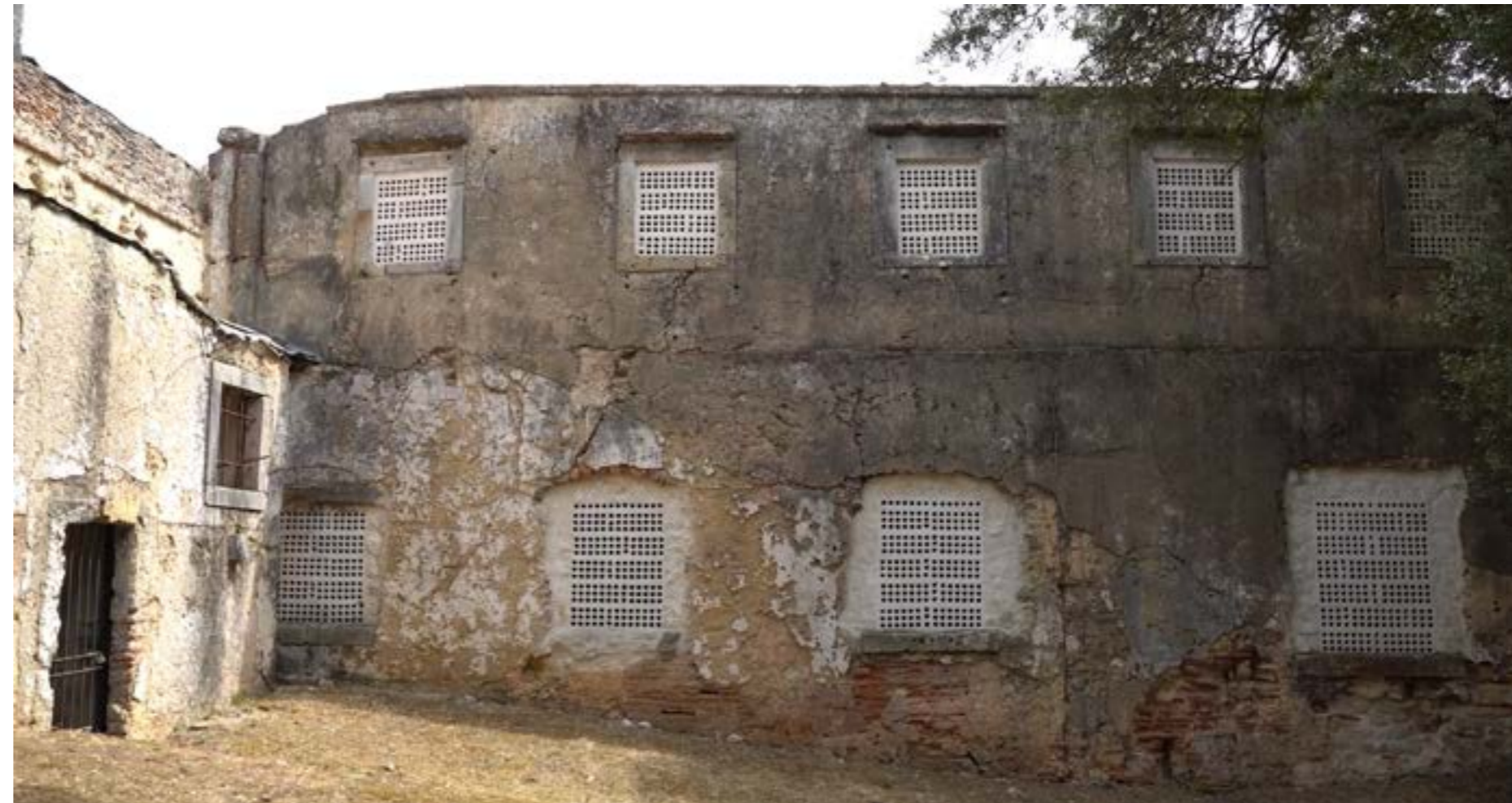
Atual fachada oeste do refeitório e celas
